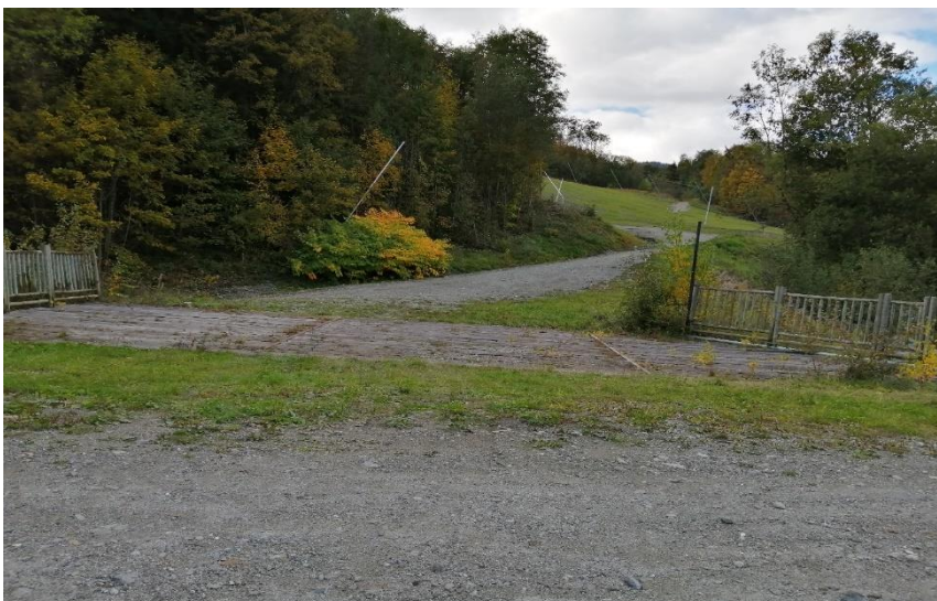
Accès au pont de la Verte
